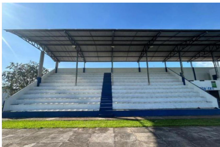
FOTO 6: PINTURA DE ESTRUTURAS METÁLICAS DA ARQUIBANCADA
